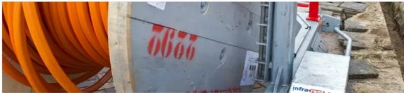
Het aanleggen van glasvezel kabelnet in Hoofddorp. Beeld ANP XTRA
